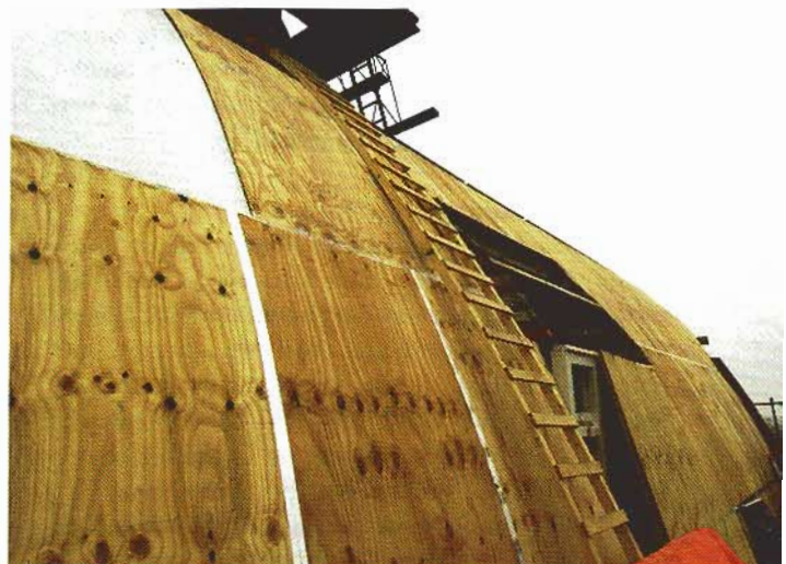
Over de binnenbeplating ligt underlayment geschroefd.
