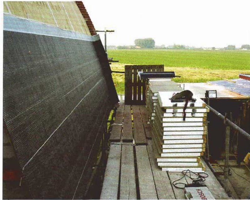
Het underlayment is voorzien van de dampremmende of sluitlaag.
