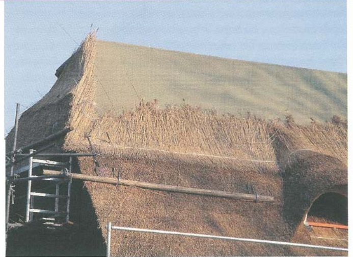
Aanbrengen van het riet op de beplating Het riet wordt niet aan bindlatten bevestigd, maar op de beplating geschroefd
